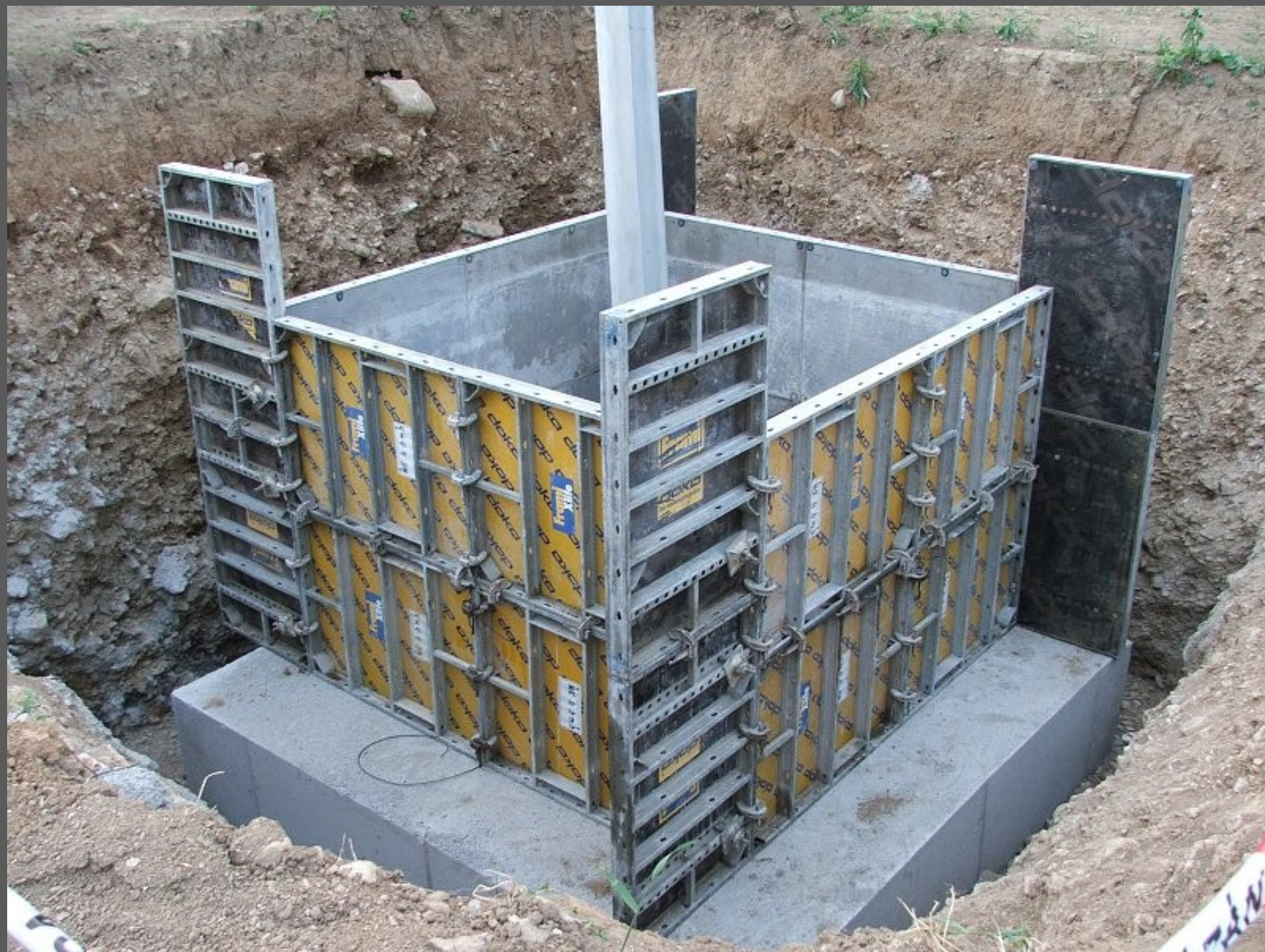
Okolo nôh konštrukcie sa upevnilo šalovanie.
