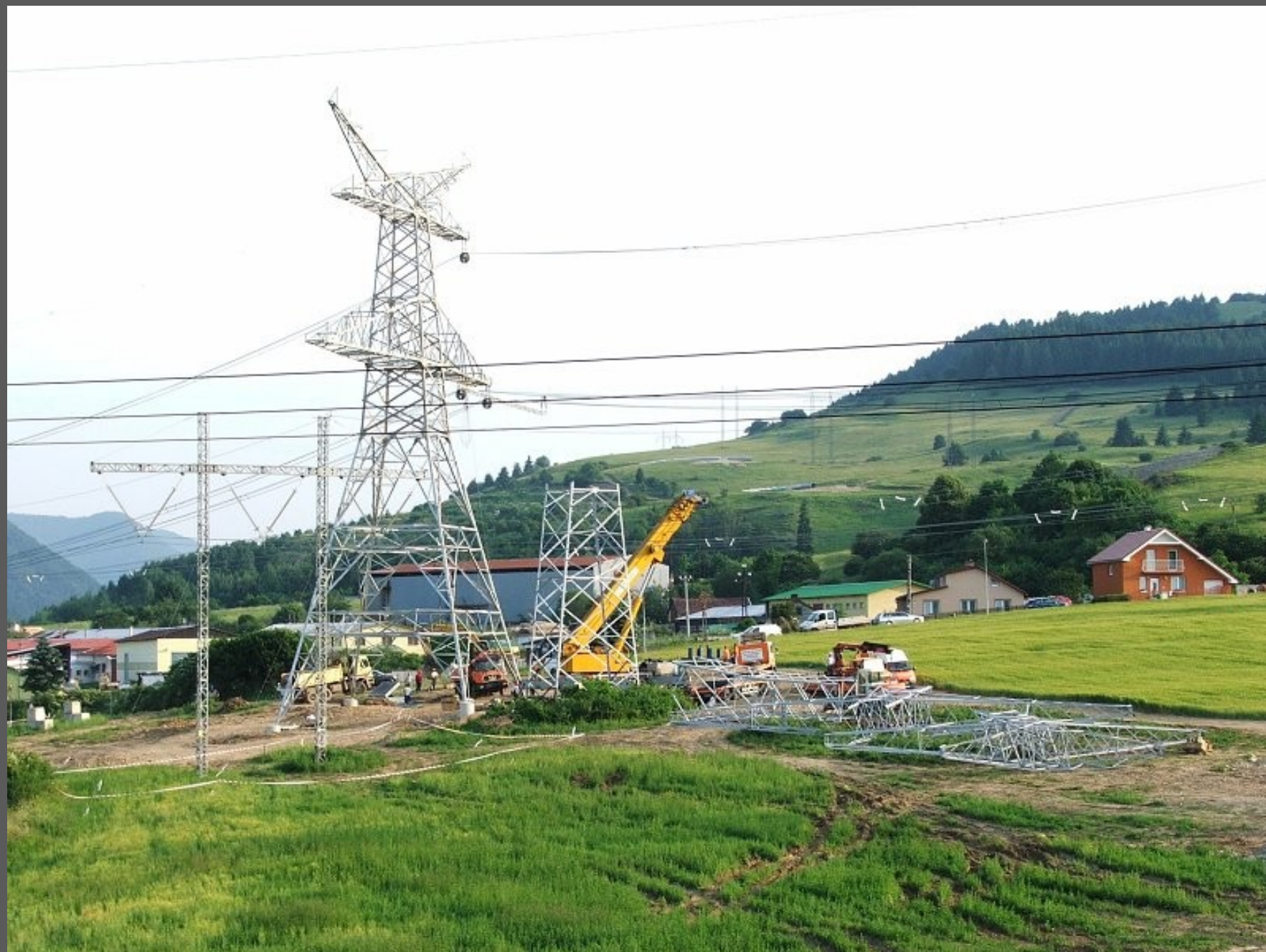
Starý stožiar (vpravo) je už čiastočne rozobratý.
