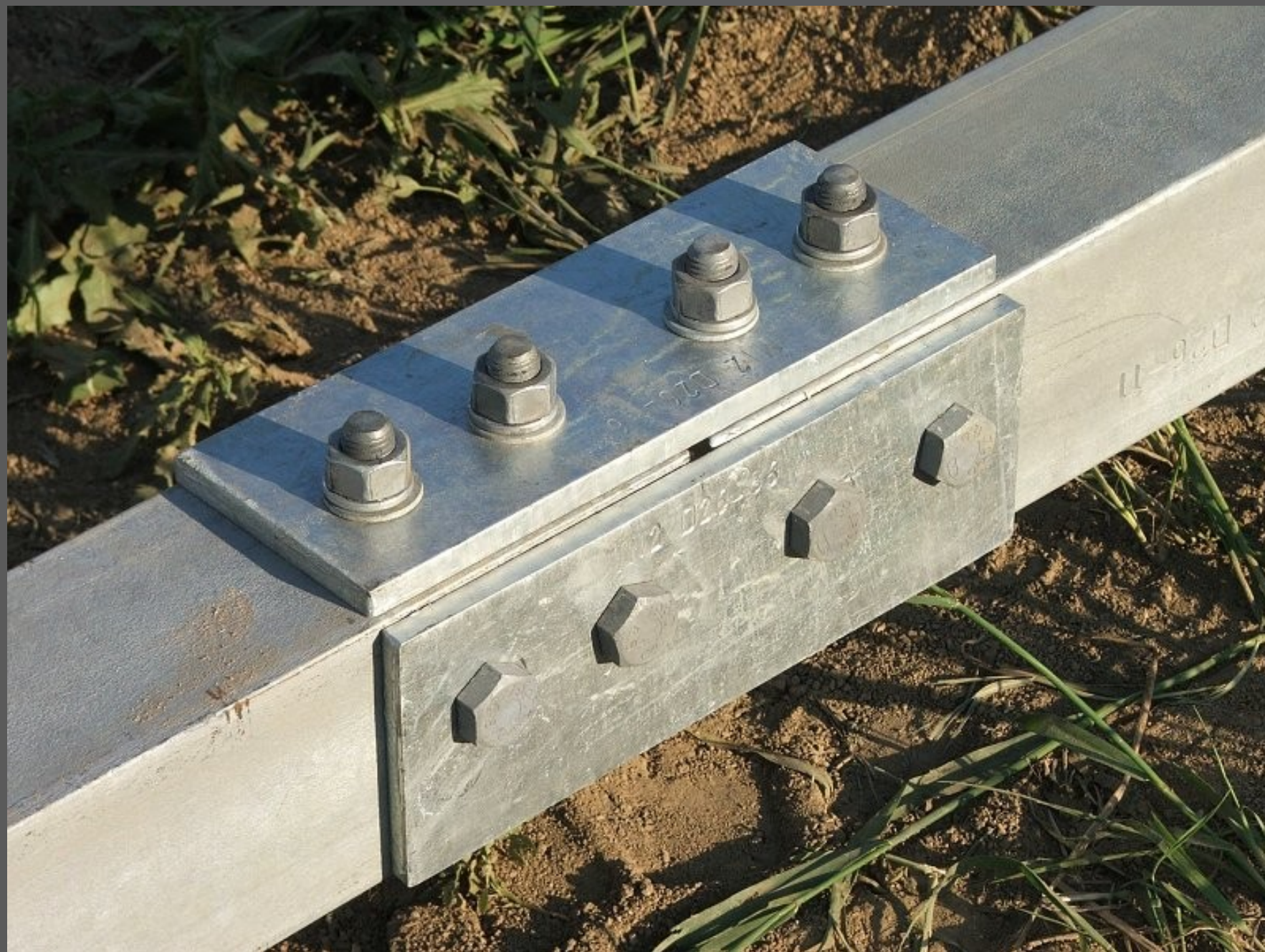
Časti budúceho diela sa spájali skrutkovými spojmi.
