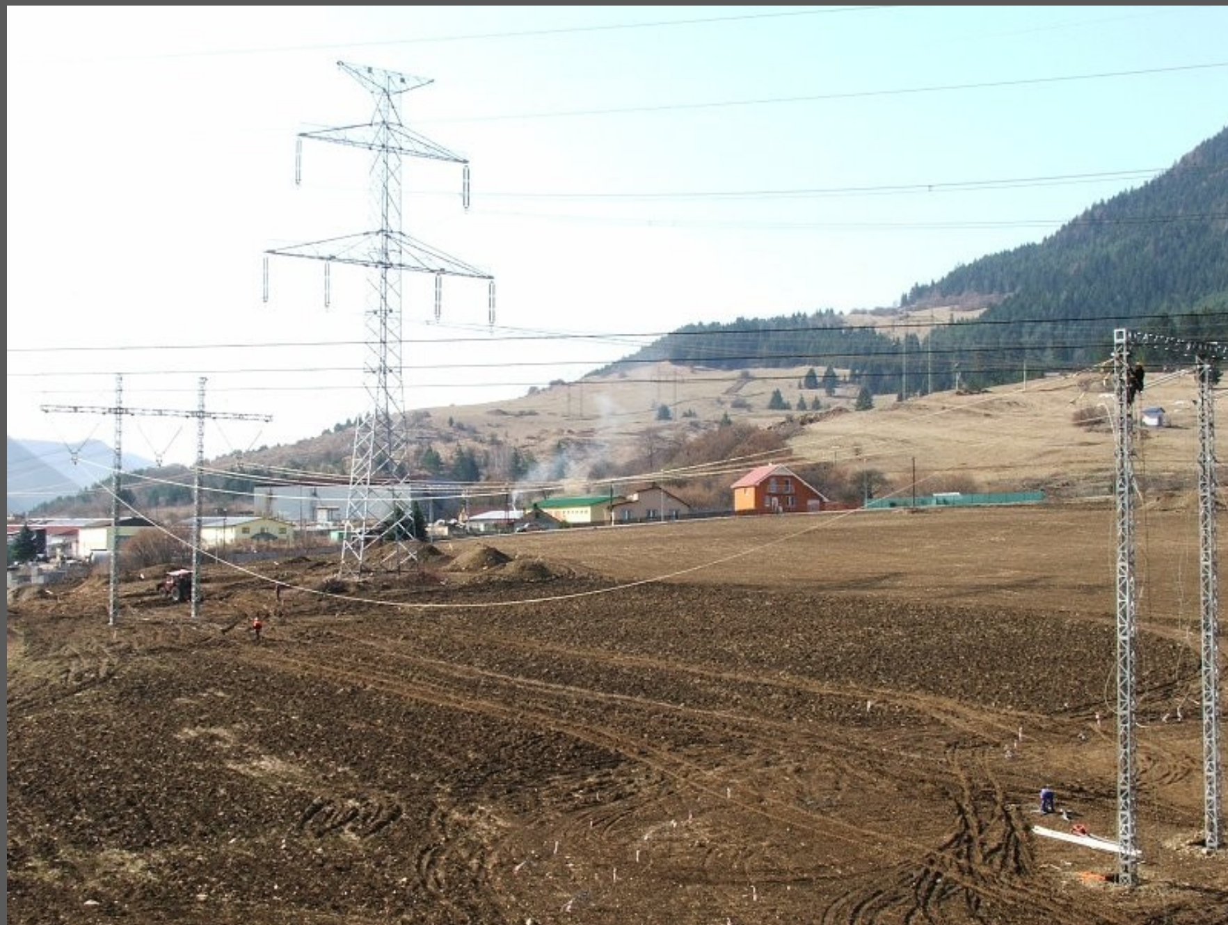
Vpredu dočasné stožiare, vzadu starý stožiar. (3. 4. 2012 10:04)
