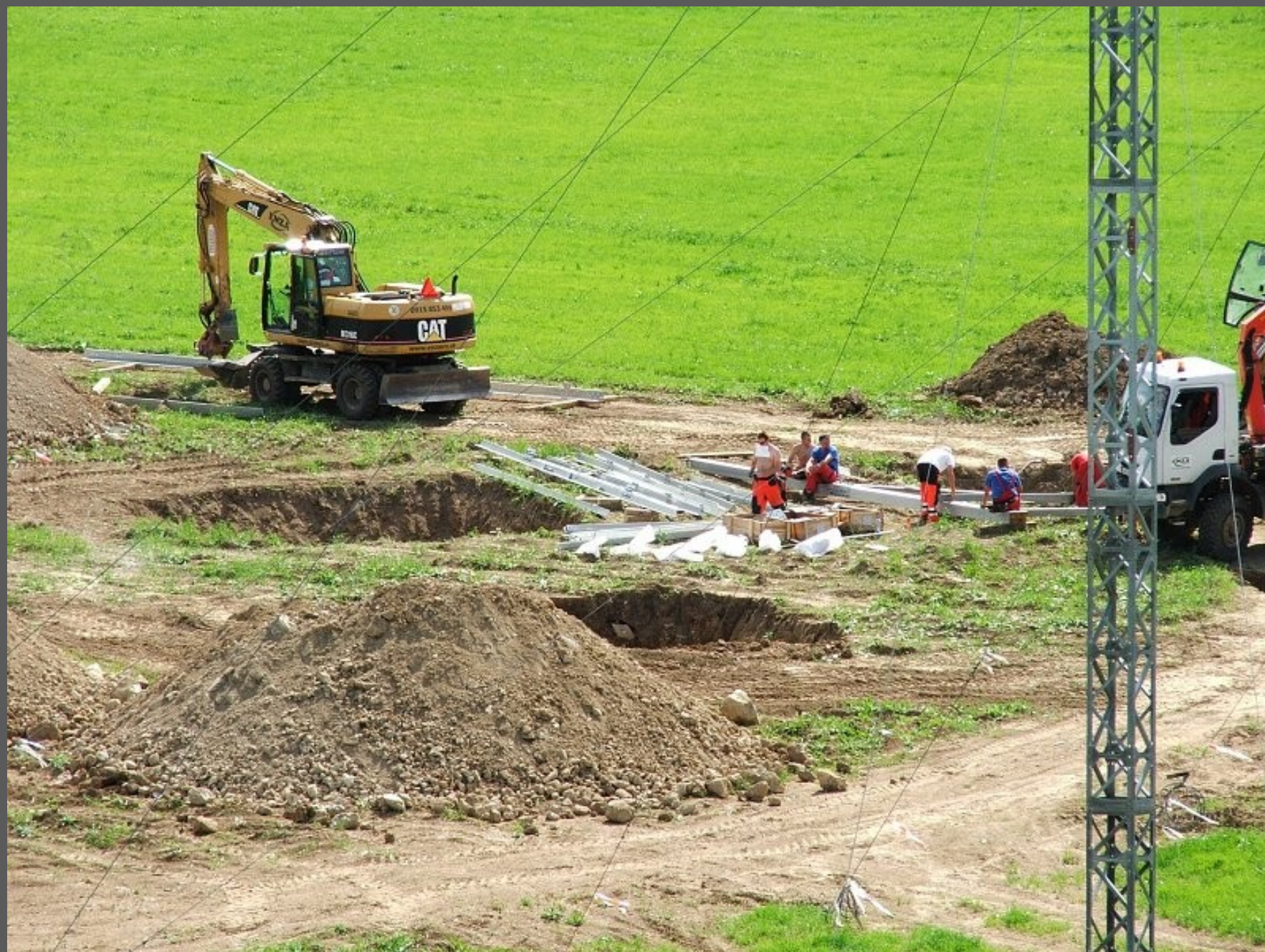
K jamám začali privážať profily a spojovací materiál.
