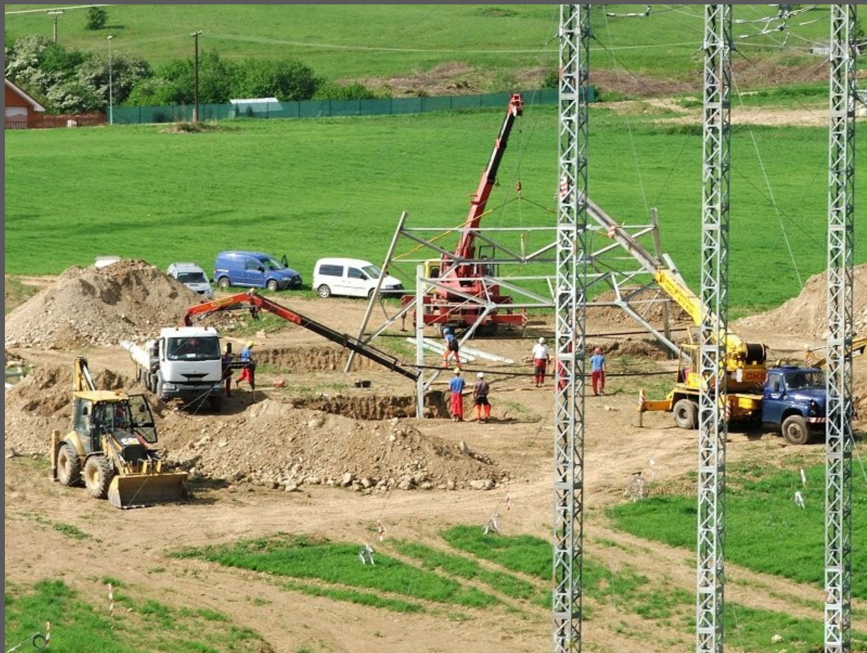
Umiestnenie protiľahlej steny konštrukcie.
