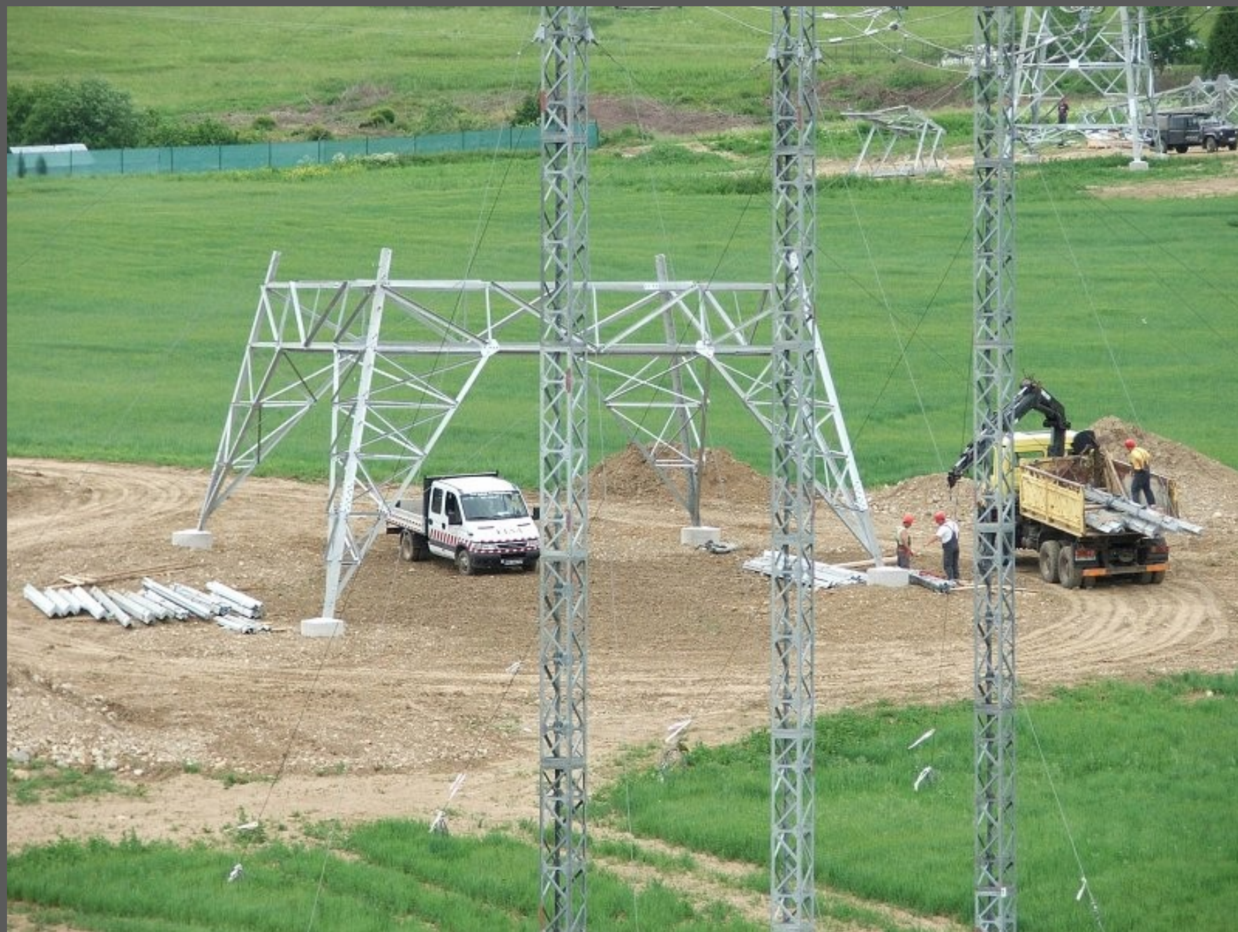
Výsledok: „prízemie“ je hotové. (9. 6. 2012) (Súčasne prebiehali aj iné práce!)
