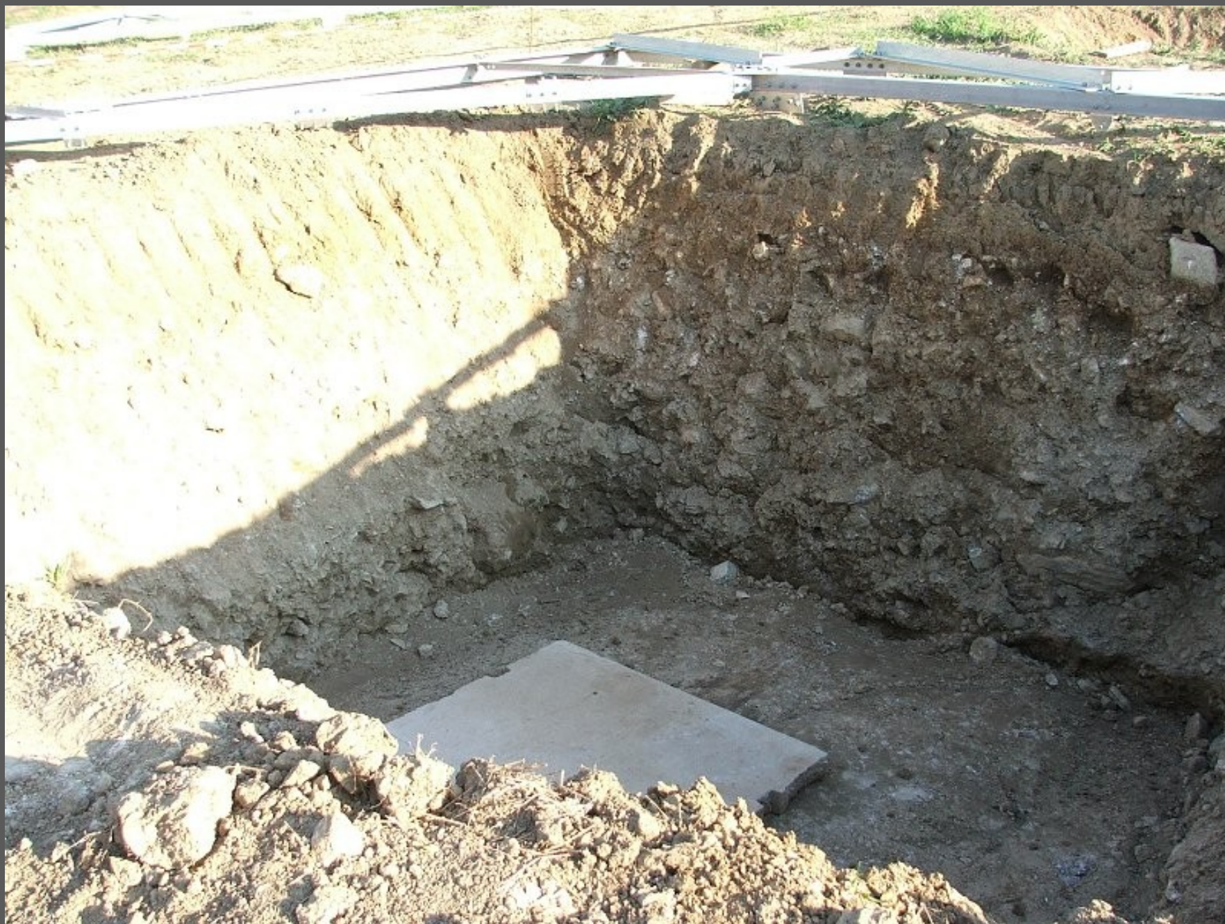
Na dná jám položili betonové platne.
