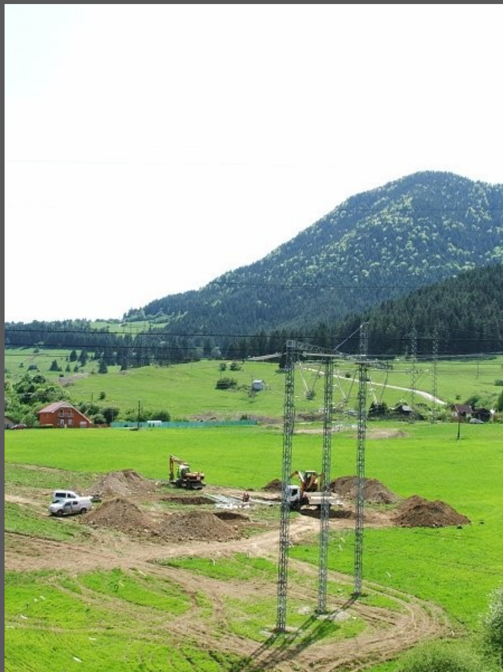
Bagrovanie štyroch obrovských jám (pre každý z troch nových stožiarov).
