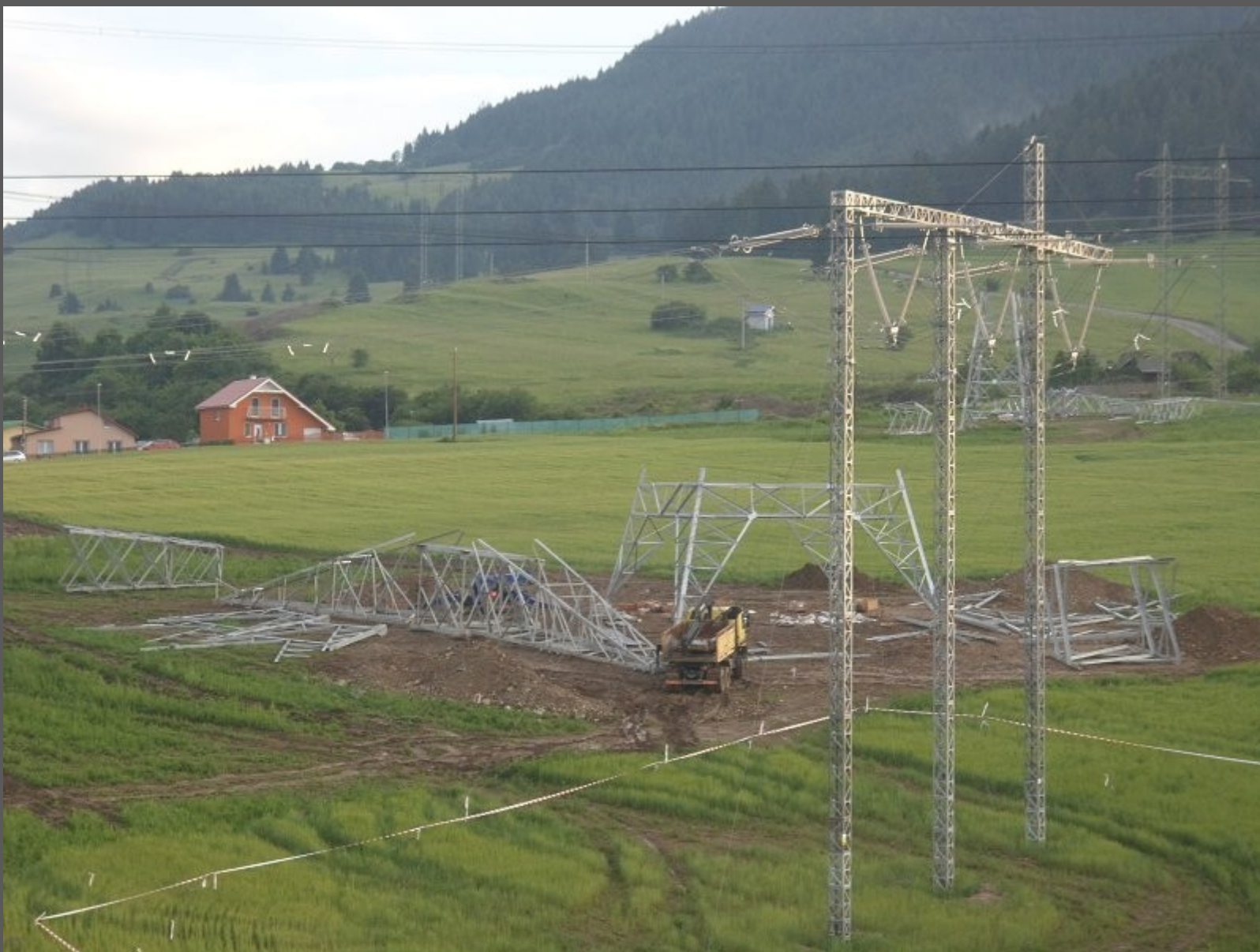
Zostavovali sa aj ďalšie časti stožiaru. (Táto fotografia je spravená už s ST93.)
